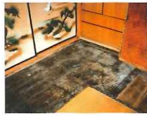
湿気により、腐朽菌が発生した床
